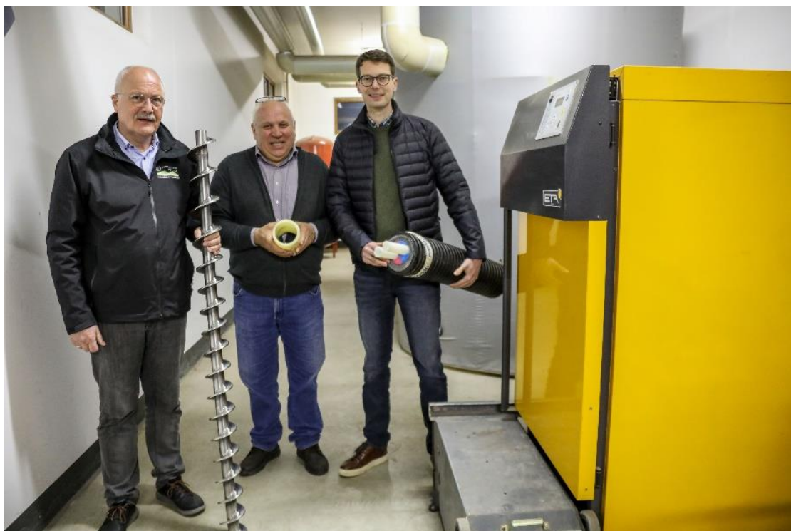
v.l.n.r.: Bürgermeister Manfred Helfrich, GbR-Vorsitzender Stefan Gensler und Sebastian Müller (MdL) im Heizhaus mit dort gelagerten Ersatzteilen für die gesamte Anlage. Zuvor hatte Stefan Gensler Im Heizhaus den weiteren Teilnehmern des Stammtisches die Arbeitsweise und Technik der Hackgutheizung erklärt und erläutert.
